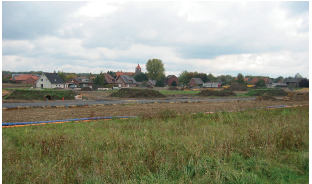
In absehbarer Zeit sollen sich im Oedinger Baugebiet Burloer Straße West die Kräne drehen.
