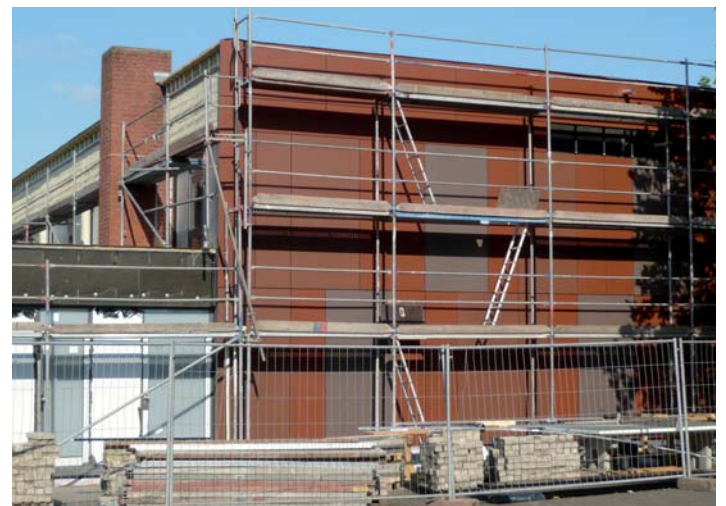
Die Turnhalle der St. Vitus-Grundschule in Südlohn während der Sanierung.
