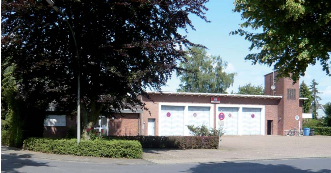
Die Oedinger Ortsmitte um das Feuerwehrgebäude soll städtebaulich aufgewertet werden.
