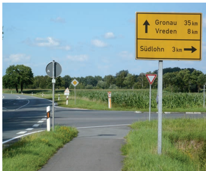
Dieser Radweg darf hier nicht mehr enden!
